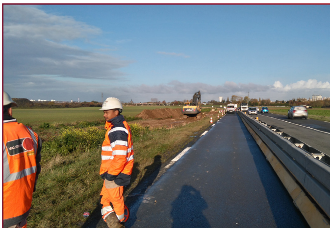
Démarrage des travaux sur la RN 17 © DREAL Hauts-de-France
